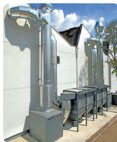
Installation de dépoussiérage avec deux modules DUSTMAC S
